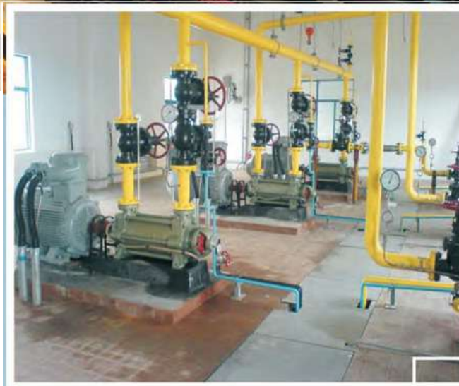
Горизонтальный многоступенчатый питательный насос котла серии DG
